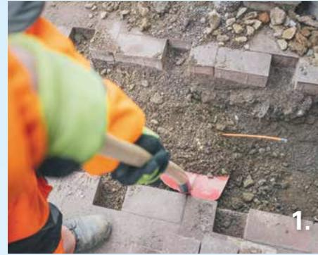
Aushub des bei den Bauarbeiten provisorisch verschlossenen Kopfloches zur Einführung des Glasfaser-Leerrohrs.
