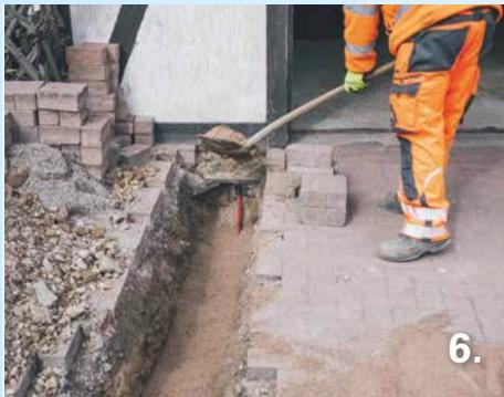
Sofern die Hauseinführung nicht sofort hergestellt werden kann, wird das Kopfloch provisorisch verschlossen und dann zur Herstellung der Hauseinführung wieder geöffnet.
