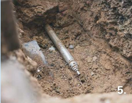
Sofern es die Gegebenheiten auf Ihrem Grundstück zulassen, wird das Leerrohr mit Hilfe der Erdrakete bis zum Kopfloch an Ihrer Hauswand verlegt. In Ausnahmefällen kann es notwendig sein, dass ein schmaler Kabelgraben ausgehoben werden muss.
