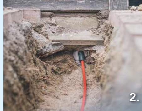
Es ist nur ein wenige Millimeter großes Loch in der Hauswand nötig, um die Glasfaser einzuleiten. Mittels einer Dichtkappe wird das Einführungsloch mit einer Schutzkappe abgedeckt und verankert.
