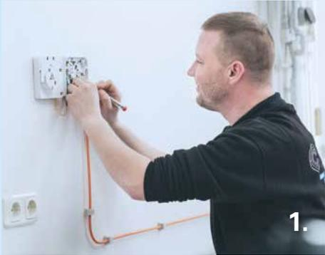
Montage des Glasfaser-Abschlusspunktes (GF-AP) an der bei der Hausbegehung festgelegten Position.
