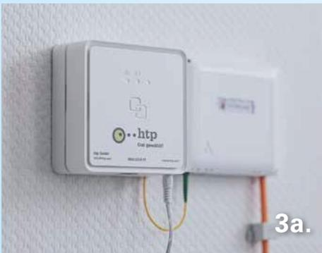
Montage des Medienconverters und Überprüfung der Verbindung. Der Anschluss Ihres Routers kann mittels Netzwerkabel direkt am Medienkonverter erfolgen. Sollte sich der Router in einem anderen Raum befinden, ist eine Netzwerkverkabelung mit Ethernet-Steckern vom Montageort des Medienconverters bis zum gewünschten »
