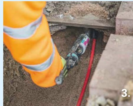
Es erfolgt die Einspritzung der Abdichtungsmasse, um das Einführungsloch gas- und wasserdicht zu verschließen.
