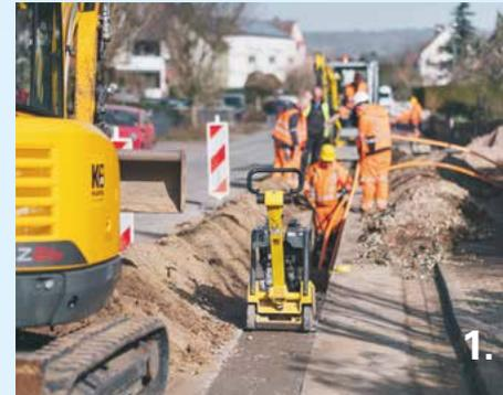
Die Bauarbeiten werden schnellstmöglich ausgeführt und die Oberflächen wieder verschlossen. In Ausnahmefällen werden komplizierte Oberflächen vorübergehend provisorisch und erst nach Abnahme durch die Gemeinde endgültig verschlossen. In die geöffneten Gräben des Gehwegs wird das Leerrohr für die Glasfaser verlegt.
