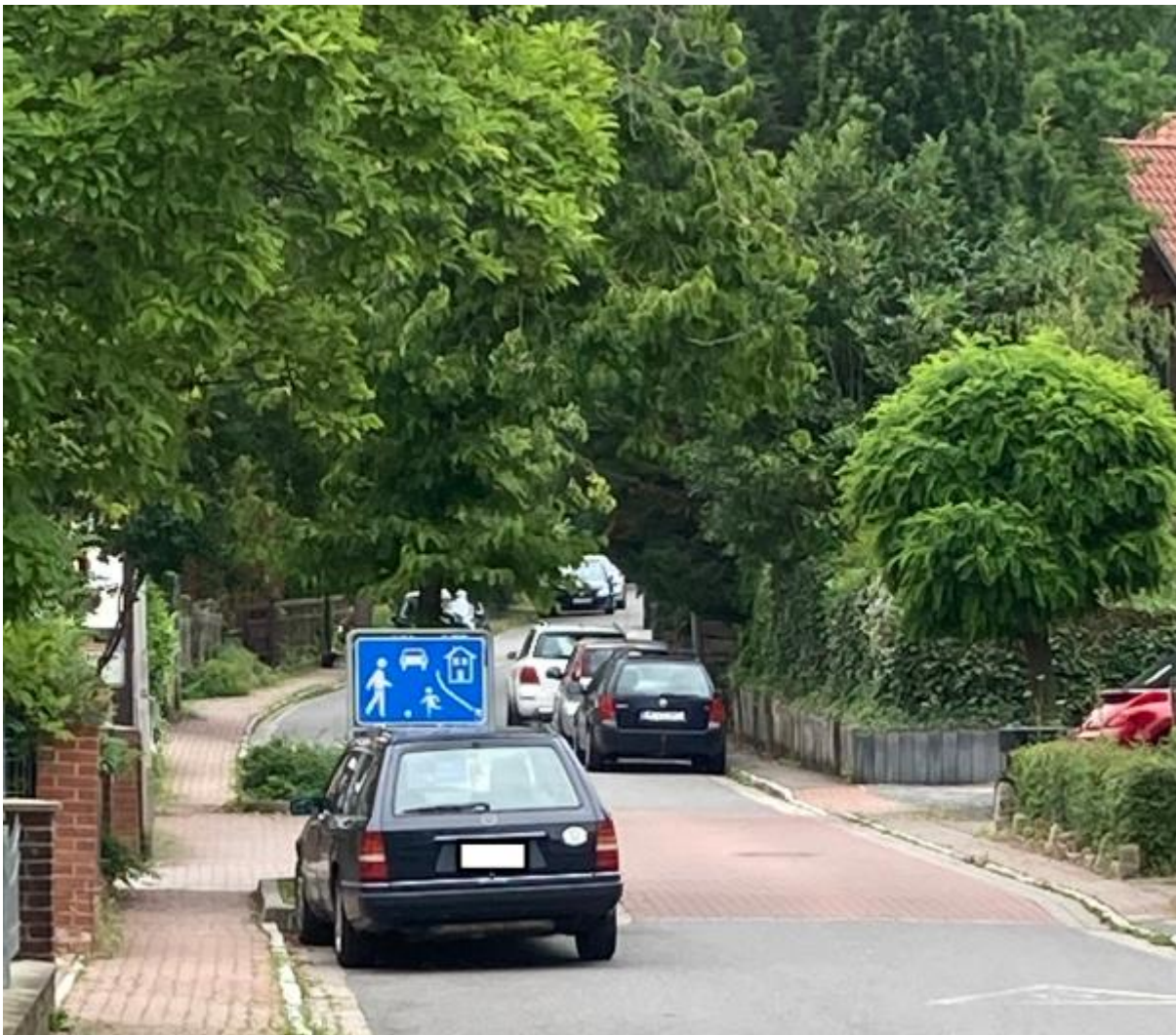
Beispielfoto für eine optische Bremse vor einem Spielstraßenbereich, eigene Aufnahme in Ronnenberg OT Benthe
