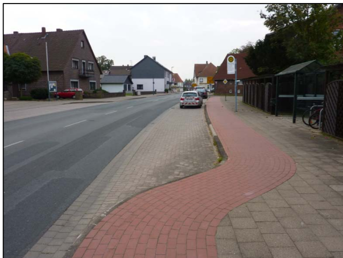
Der Radweg unterscheidet sich in Teilbereichen baulich deutlich vom Gehweg. Ein Sicherheitstrennstreifen zu parkenden Kfz fehlt.
