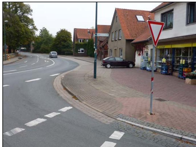
Nicht benutzungspflichtiger baulicher Radweg mit geringer Trennwirkung zum Gehweg
