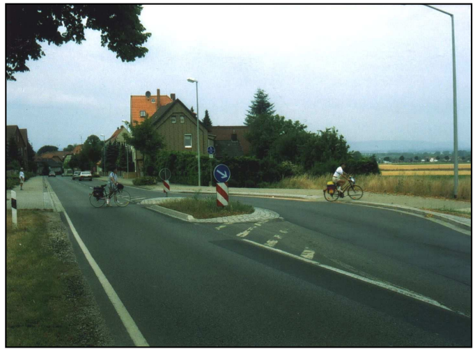
Bild 16: Mittelinsel an einer Ortseinfahrt zur Sicherung der Querung zu einem einseitigen Radweg auf der freien Strecke
