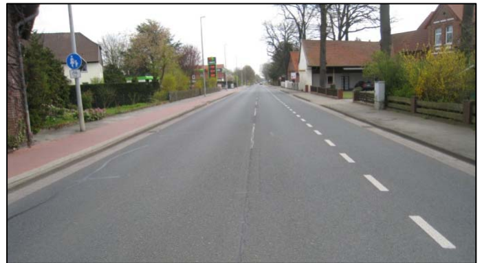
Gehweg / Radverkehr frei auf der in Fahrtrichtung linken Seite und Schutzstreifen in der gleichen Richtung
