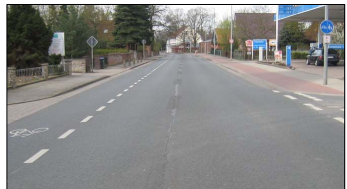
Getrennter Rad- und Gehweg mit Benutzungspflicht in Fahrtrichtung auf der rechten Seite
