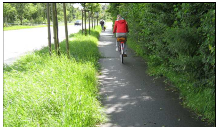
Geringe Breite des Weges für Begegnungen mit Fußverkehr
