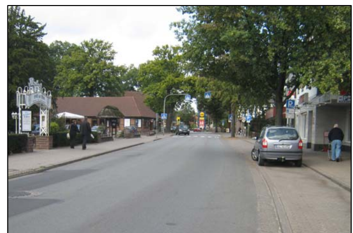
Zustand der Ortsdurchfahrt vor dem Umbau
