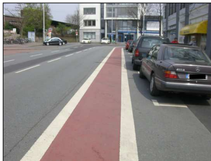
Bild 10: Radfahrstreifen in einer Ortsdurchfahrt neben Längsparkständen
