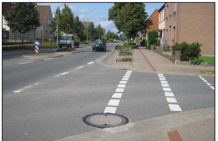
Radweg mit Furtmarkierung über Einmündung
