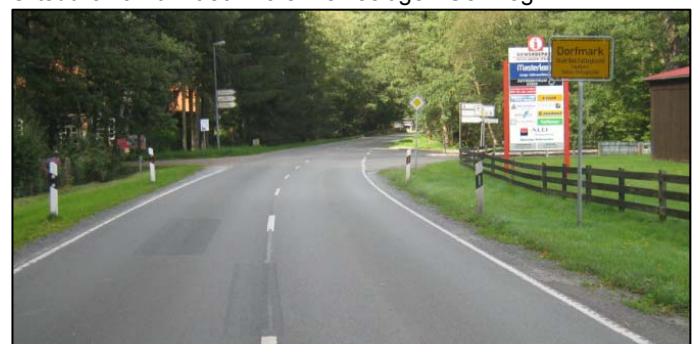
Beginn der Ortsdurchfahrt zunächst ohne Gehweg
