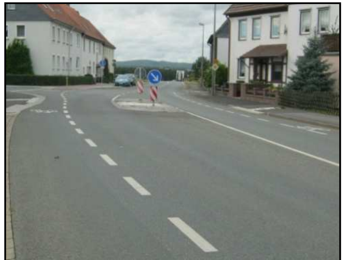
Bild 22: Übergang eines gemeinsamen Geh- und Radweges für Zweirichtungsradverkehr (auf der in Blickrichtung linken Fahrbahnseite hinter der Einmündung) in einen Schutzstreifen im Zuge der OD. In der Gegenrichtung (ortsauswärts) Möglichkeit zur gesicherten Querung im Schutz der Mittelinsel.
