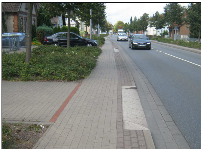
Bild 9: Baulicher Radweg mit Radwegüberfahrten und Rampensteinen
