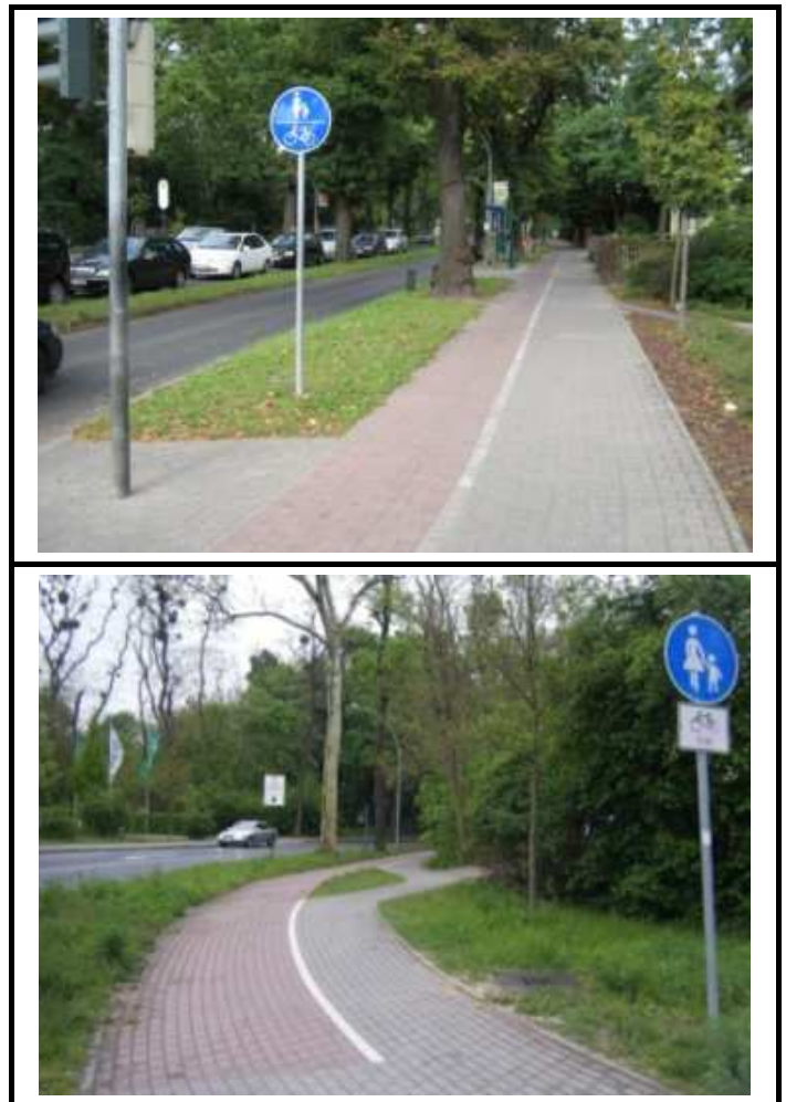
Bild 23: Ausweisung eines früher getrennten Rad- und Gehweges als „gemeinsamer Geh- und Radweg“ (oben) bzw. als „Gehweg / Radverkehr frei“ (unten) trotz weiterhin erkennbarer baulicher Trennung
