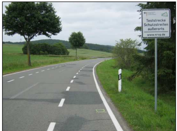
Bild 13: Teststrecke Schutzstreifen außerorts im Landkreis Nordheim
